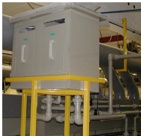
Bild 4: Filterstation mit freihängenden Filterbeuteln (Wartungstüren geschlossen), die Wartungstüren können auch transparent sein.
